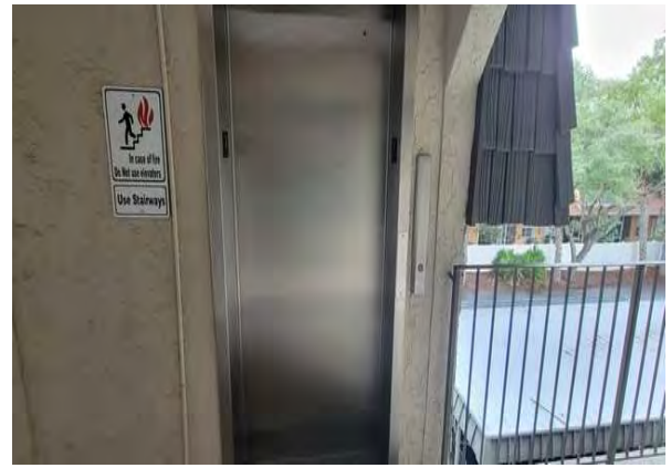
26 Elevator Door Overview
